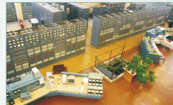
Панели управления физическими моделями элементов энергетического оборудования
