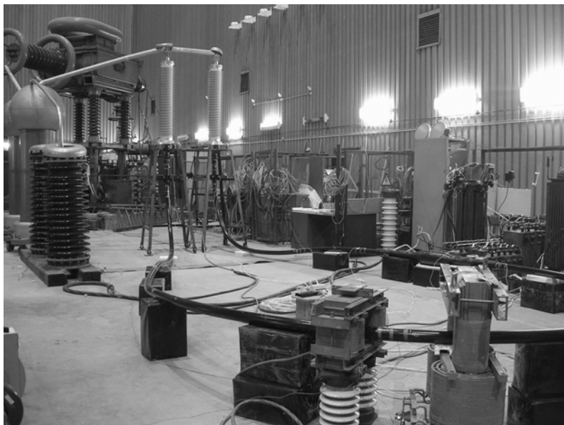
Рис. 1. Фотография испытываемой кабельной системы 110 кВ
