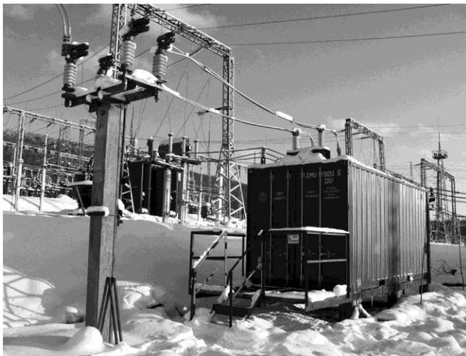
**Рис. 2.** Общий вид выпрямителя на ПС 220 кВ Тымовская
