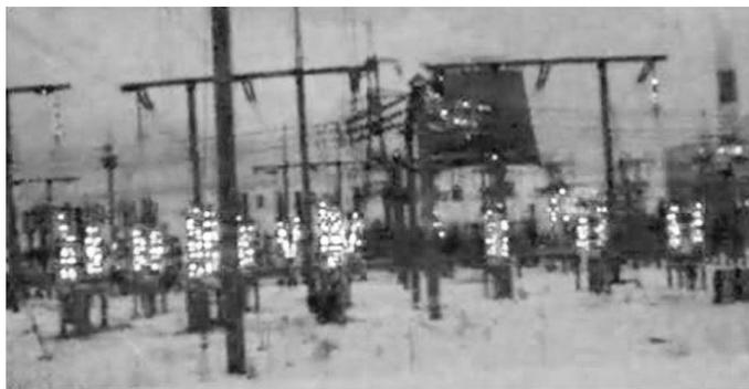
**Рис. 1.** Многочисленные дуговые разряды на внешней изоляции электрооборудования ОРУ ПС «Южная»
