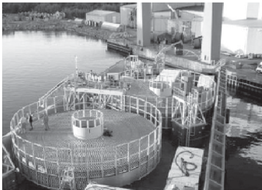
Рис. 3. Погрузка кабеля с завода-изготовителя на судно-укладчик
