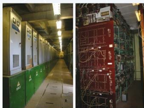
Силовые трансформаторы и линии электропередачи
