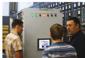
Испытания ГРАМ Усть-Каменогорской ГЭС
