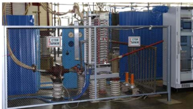
Рис. 2. БВТВ и ШУ в процессе нагрузочных испытаний
