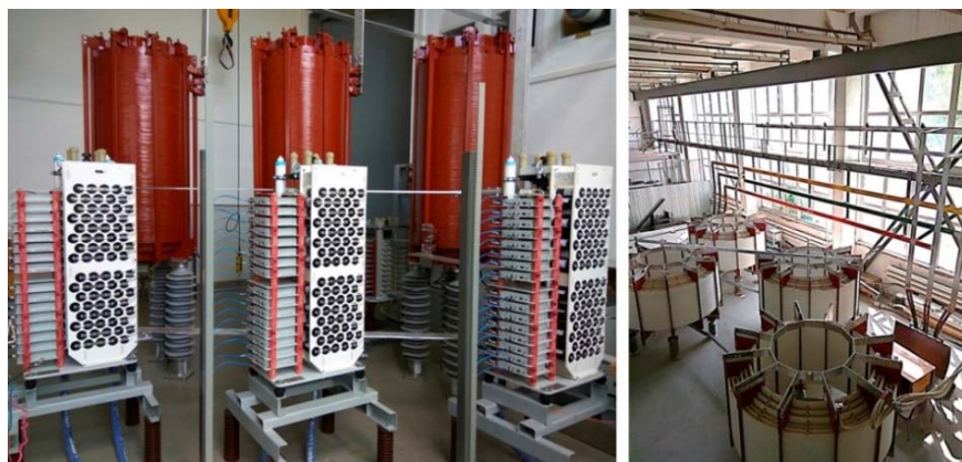
Рис. 7. БВТВ-835/8,27 УХЛ 4.2 (на переднем плане), РФзОС-20-2200-0,03 УЗ (на заднем плане) и РСС-20-2500-0,63 УХЛ1 (справа) в составе 3-пульсной кольцевой испытательной схемы
